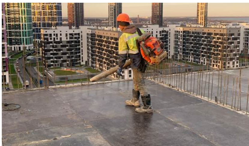
Рис. 1. Проведение очистки опалубки
