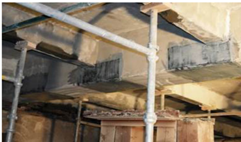
Рис. 2, б. Усиление безбалочного железобетонного перекрытия углекомпозитными лентами
