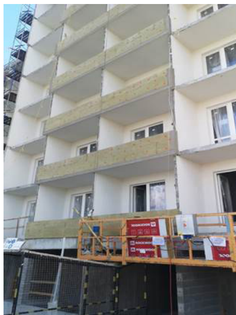
Рис. 2. Устройство фасадов жилого дома с применением люлек
