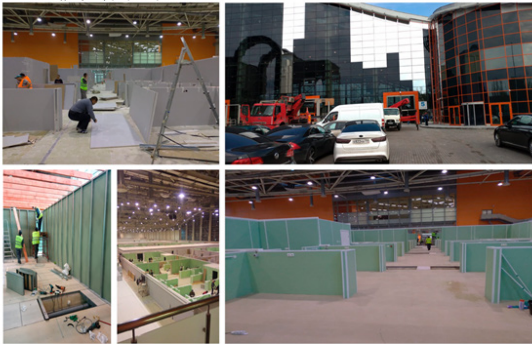
Рис. 1. Пример реконструкции павильона № 75 ВДНХ
