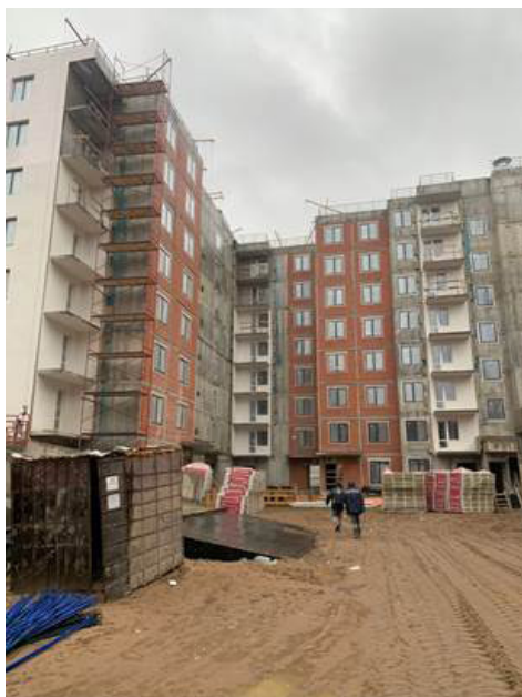
Рис. 1. Устройство фасадов жилого дома с применением фасадных лесов
