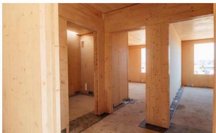
Рис. 3. Строительство многоэтажного жилого дома из CLT-панелей, г. Сокол [13]
