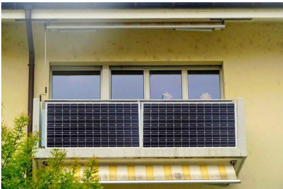
Рис. 4. Способ установки солнечных панелей Хевел на балкон
