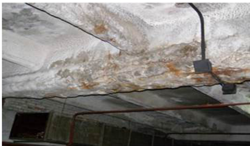
Рис. 2, а. Железобетонное перекрытие до усиления
