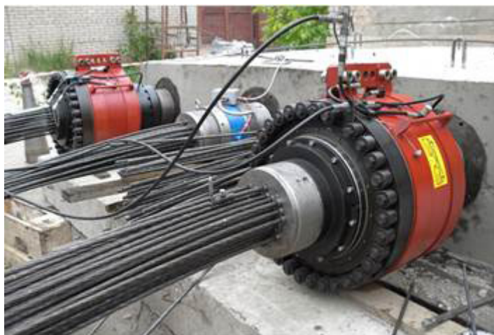
Рис. 4. Железобетонное перекрытие, усиленное преднапряженной арматурой
