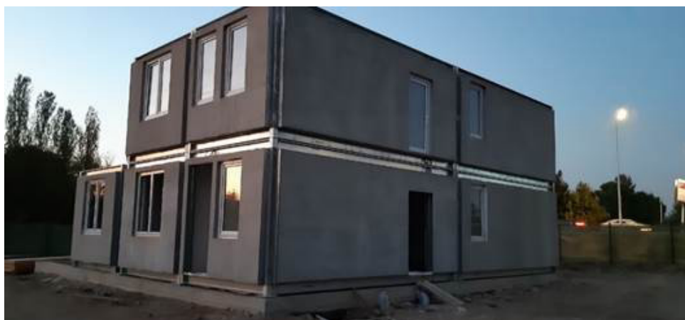
Рис. 2. Строительство таунхауса, блокированного из Prefab-модулей в г. Хельсинки [8]
