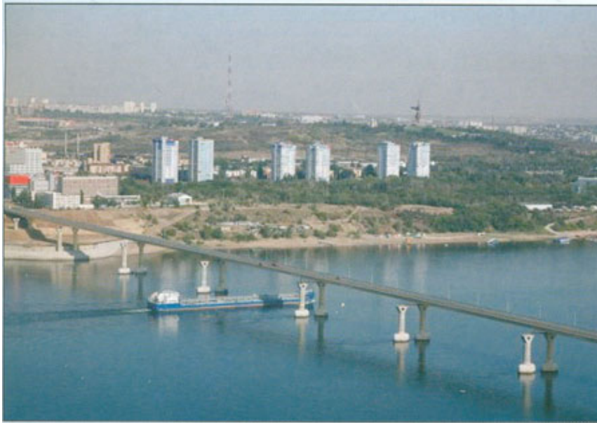
Рис. 8.4. Мост через Волгу в Волгограде
