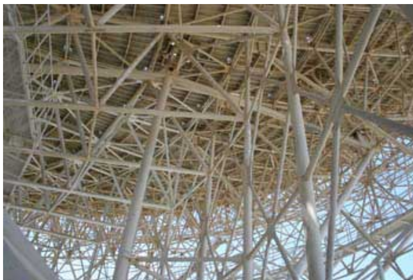
Рис. 6.13. Фрагмент каркаса ГЗ
