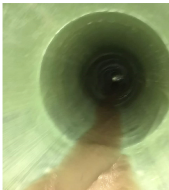
Рис. 5. Поверхность тела трубы после завершения работ
