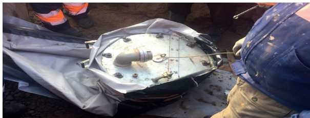
Рис. 3. Монтаж пакера
