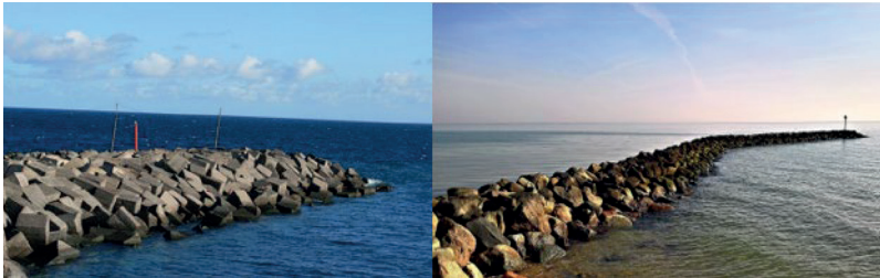
Рис. 2. Блочно-бетонный и блочно-каменный волноломы
