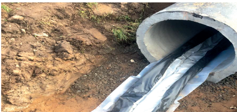
Рис. 2. Монтаж рукава
