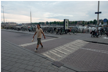
Рис. 5. Возвышение перехода и мощение плиткой, Москва [9]
