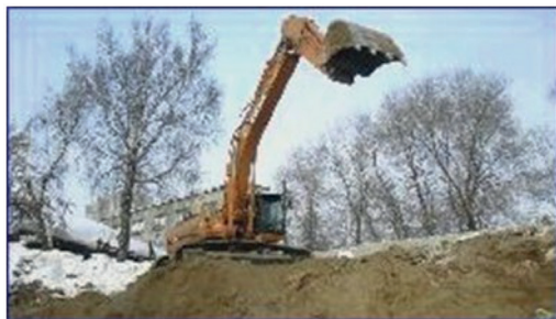
Рис. 1. Изображение работающего ковшового экскаватора
