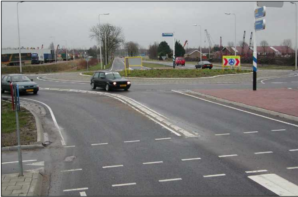
Рис. 6. Пример разделителя спирального кольцевого пересечения в Нидерландах [5]
