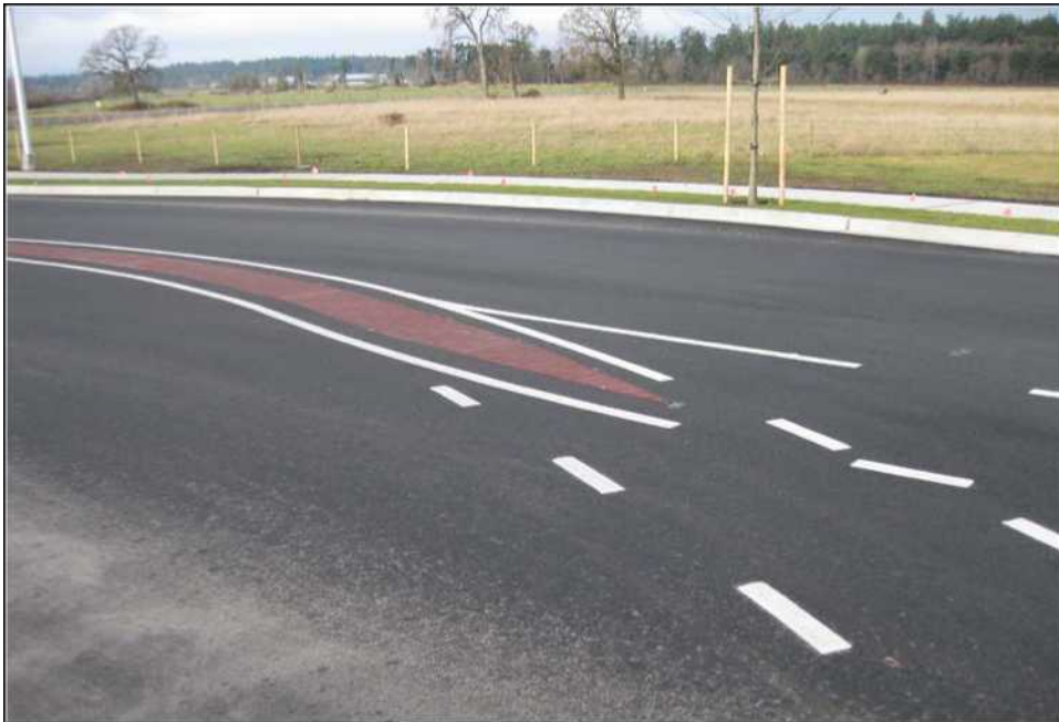
Рис. 7. Пример начала разделителя спирального кольцевого пересечения в Канаде [1]
