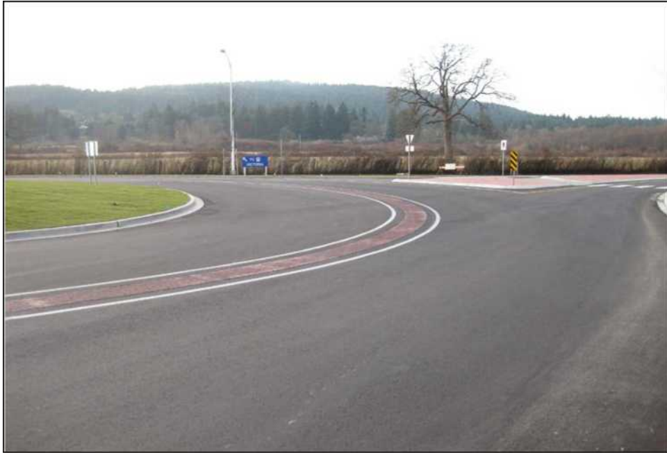
Рис. 8. Пример начала разделителя спирального кольцевого пересечения в Канаде [1]
