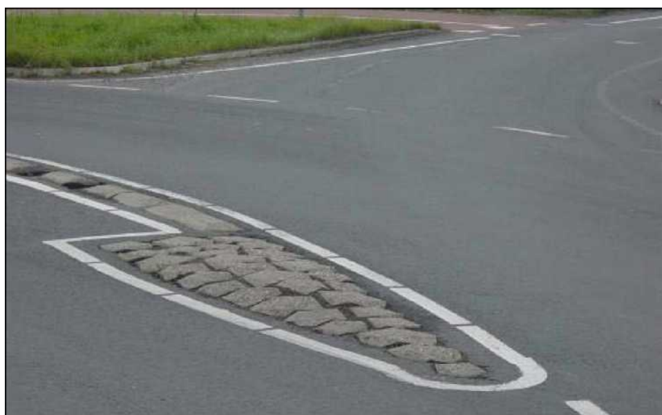
Рис. 5. Пример начала разделителя спирального кольцевого пересечения в Нидерландах [5]
