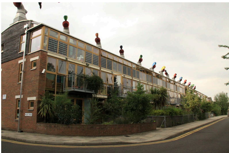
Рис. 5.9. Устройства для активизации естественной вентиляции жилого дома. Хагбридж. Комплекс Bed-zed. Фото В. Линова
