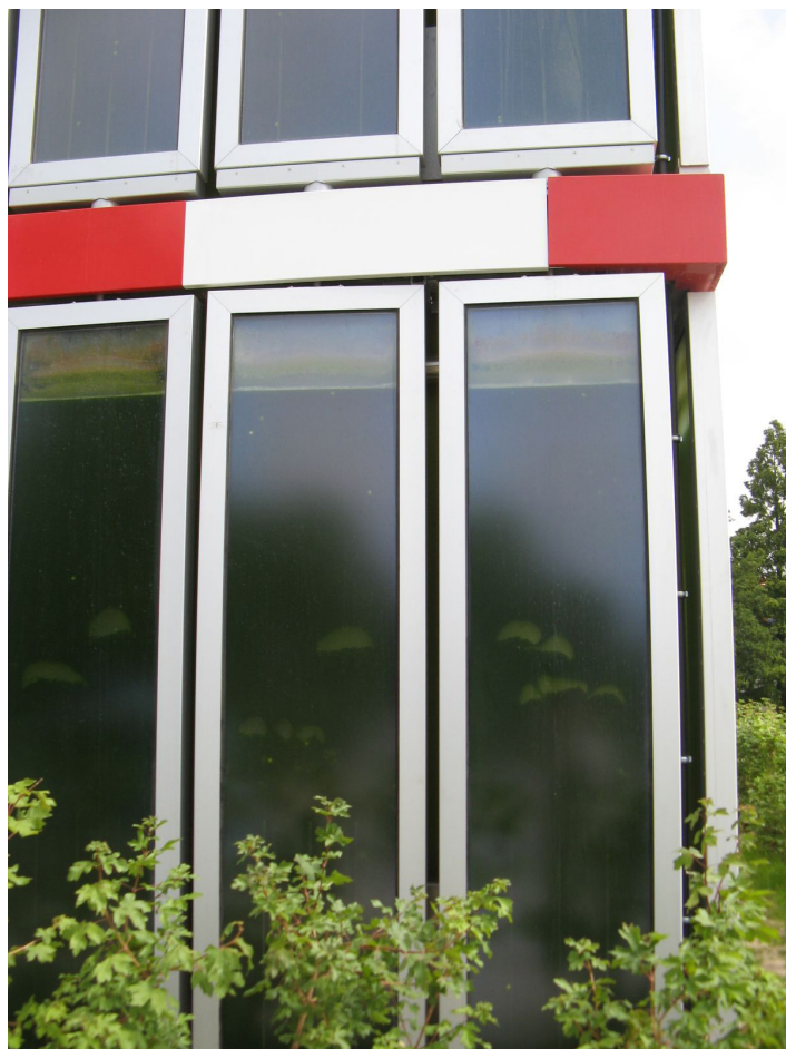
Рис. 5.8. Фасадные элементы, производящие биомассу для выработки энергии. Гамбург. Международная строительная выставка. Фото В. Линова
