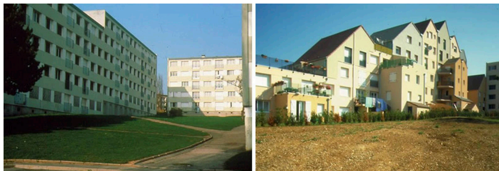
Рис. 12.1. Жилое здание до и после реконструкции. Архитектор Люсьен Кроль.
