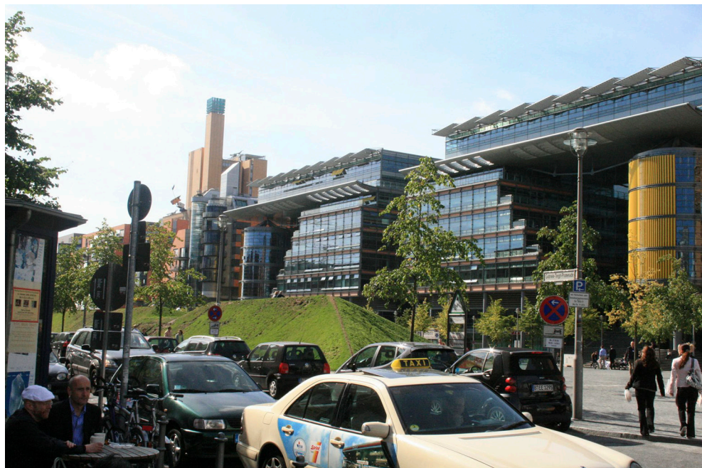
Рис. 5.3. Пример членения объёмов зданий в плане и по высоте. Берлин. Район Потсдамерплац. Фото В. Линова
