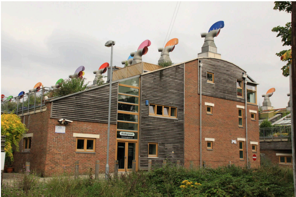
Рис. 10.2. Расширение корпуса здания за счёт совмещения жилых и общественных функций. Комплекс BedZED. Хагбридж, Великобритания. Фото В. Линова
