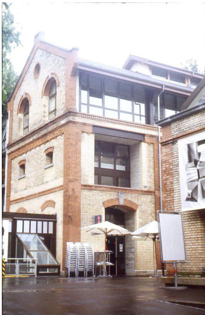
Рис. 11.3. Реконструкции фабрики в Цюрихе (Швейцария). Фото В. Линова
