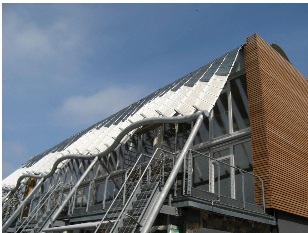
Рис. 10.7. Установка вращающихся вслед за солнцем солнечных коллекторов. Гамбург. Международная строительная выставка. Фото В. Линова
