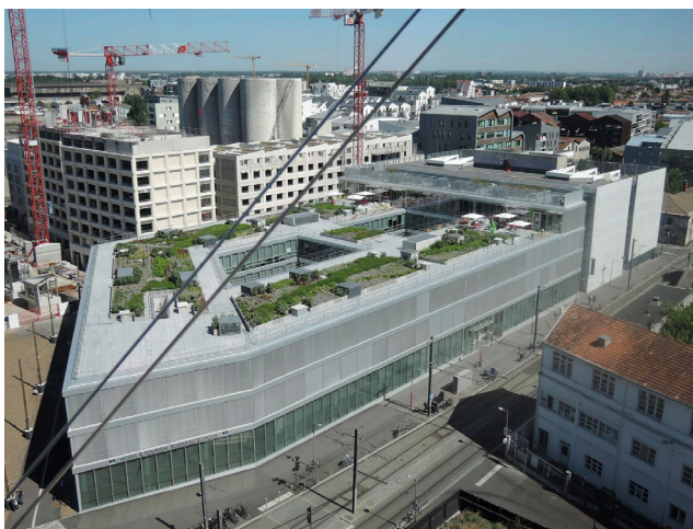
Рис. 15.6. Центр района Речные бассейны. Здание школы туризма. Бордо. Фото В. Линова
