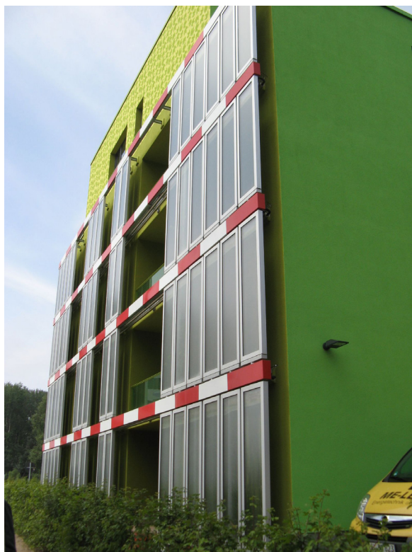
Рис. 10.12. Экспериментальный дом «Фотосинтез» с производством биомассы на фасаде. Гамбург, Международная строительная выставка. Фото В. Линова
