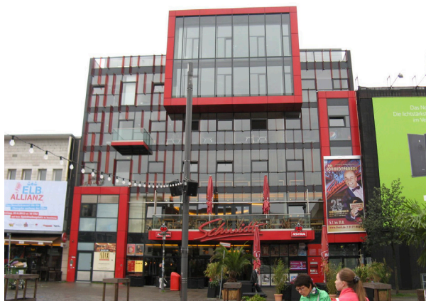
Рис. 5.5. Пример архитектурного решения первого этажа в уличном пространстве. Гамбург. Фото В. Линова
