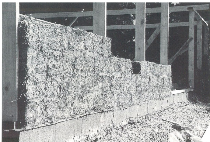
Рис. 10.13. Строительство из известково-соломенных блоков.
