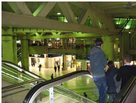
Рис. 5.4. Пример подземного пространства транспортного и торгового назначения. Париж, Форум. Фото В. Линова
