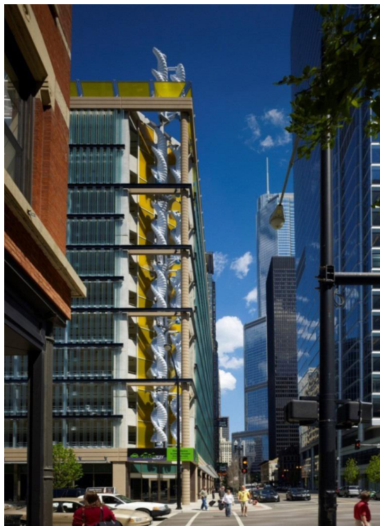
Рис. 10.10. Вертикальные ветрогенераторы на углу здания. Чикаго, США.
