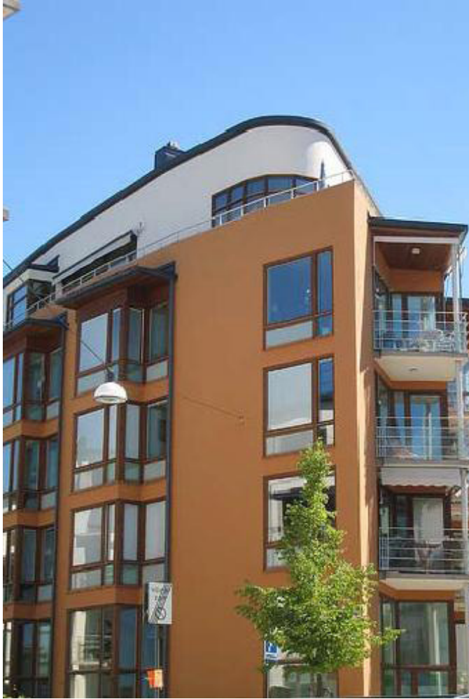
Рис. 13.8. Хаммарбю Шёстад. Фрагмент жилой застройки. Источник: [57, с. 51]
