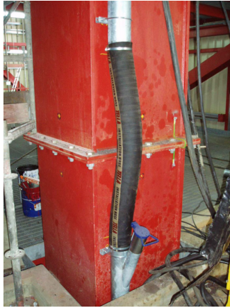
Рис. 4.40. Узел обхода препятствия
