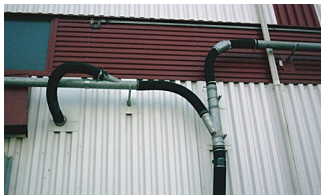
Рис. 4.39. Система всасывающего пневмотранспорта с резиновыми шлангами
