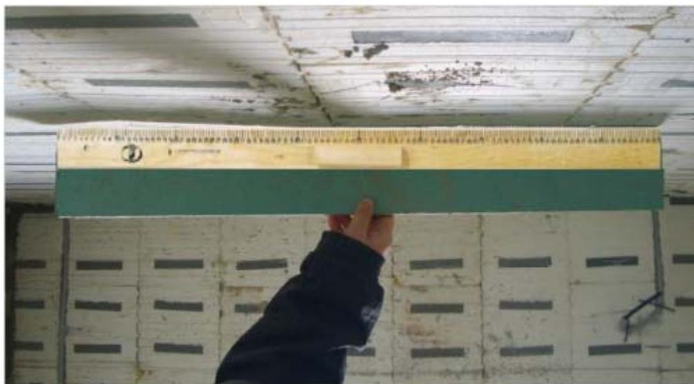
Рис. 1. Выявленные отклонение поверхности потолка от проектного положения
