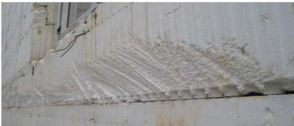
Рис. 4. Фрагмент наружной стены, подготовленный для отделочных работ
