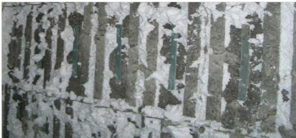
Рис. 3. Фрагмент стены с удаленным слоем пенополистирола
