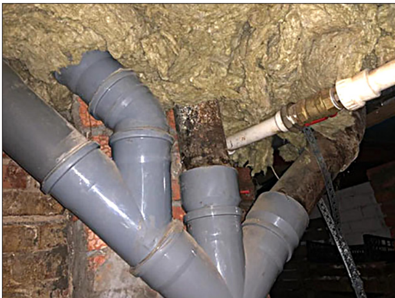
Рис. 2. Пример подключения новых инженерных сетей к существующим
