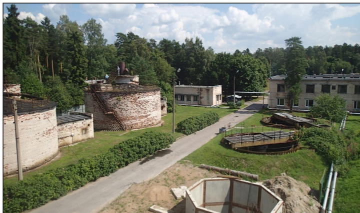
Рис. 1. Общий вид на комплекс очистных сооружений
