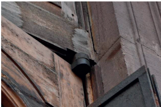
Рис. 4. Пятниковая петля в верхнем обвязочном бруске
