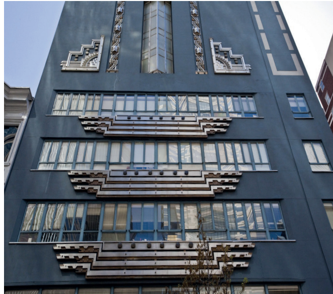
Рис. 2. Фрагмент фасада здания WCAU Building
