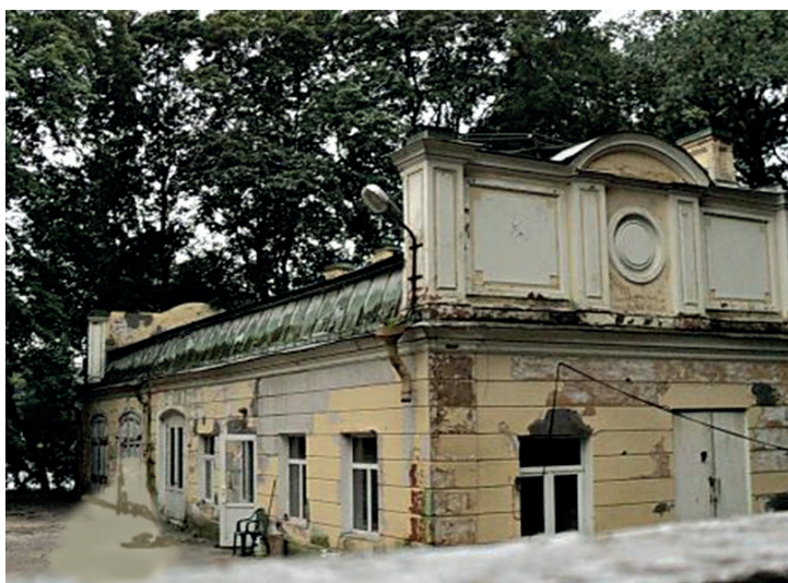
Рис. 5 Служебный корпус до начала строительных работ. 2009 г.
