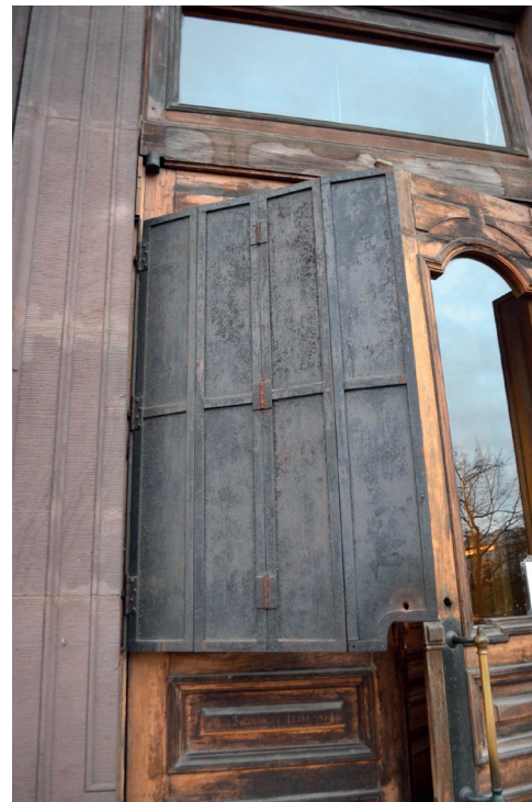
Рис. 5. Накладные петли на ставнях
