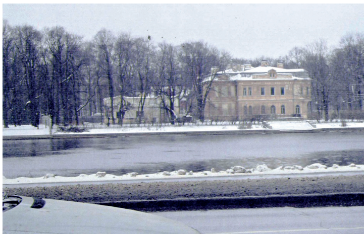
Рис. 3. Общий вид построек с набережной Малой Невки до начала реставрационных рабов. 2009 г.
