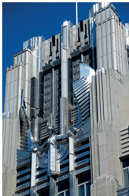
Рис. 7. Деталь фасада здания Niagara Mohawk в Сиракузах
