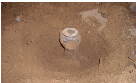
Рис. 3.3.7. Оголовок испытываемой сваи-РИТ с шипами
