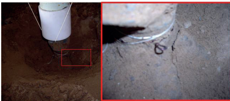
Рис. 3.3.11. Надлом шиповидных уширений свай-РИТ
