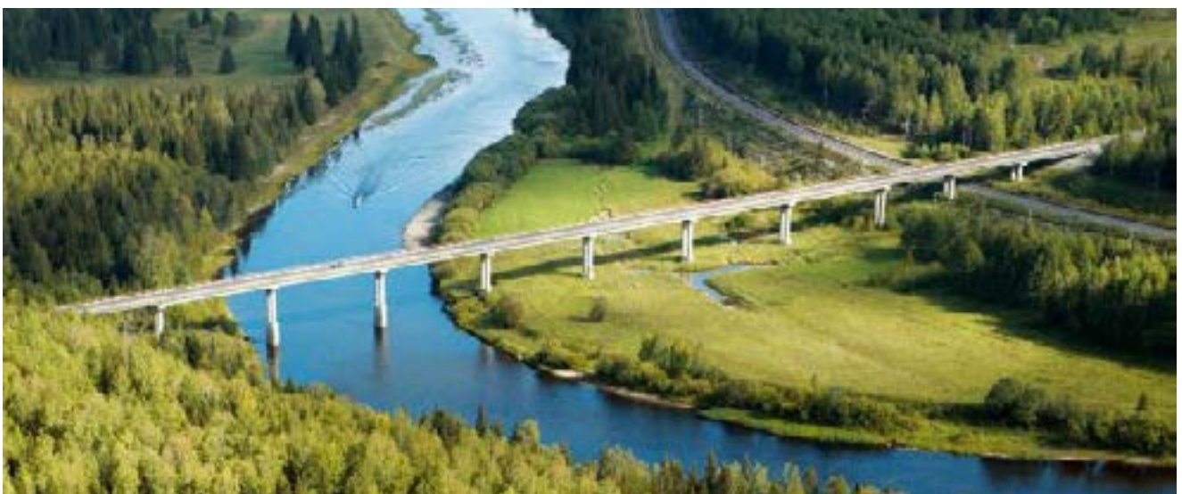
Рис. 4,б. Мостовое сооружение через р. Ухта вблизи г. Сосногорск в республике Коми
