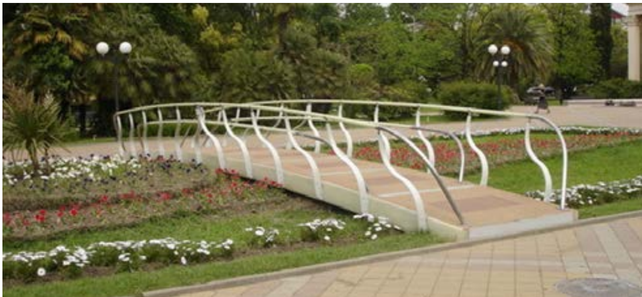
Рис.5. Цельнокомпозитный мостик-переход в г. Сочи
