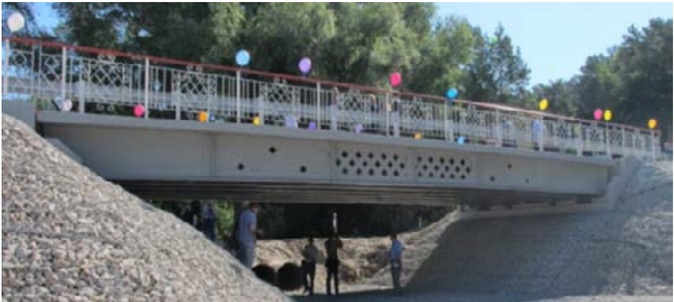
Рис. 6. Первый в России автодорожный мост из композитных материалов, р.Пашенка, Сибирь
