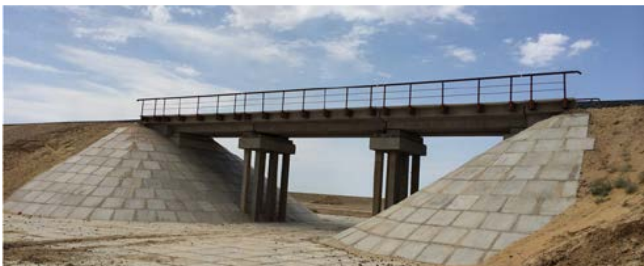
Рис.2. Скотопрогон на ПК657 железнодорожного участка Шалкар-Бийнеу, Казахстан
