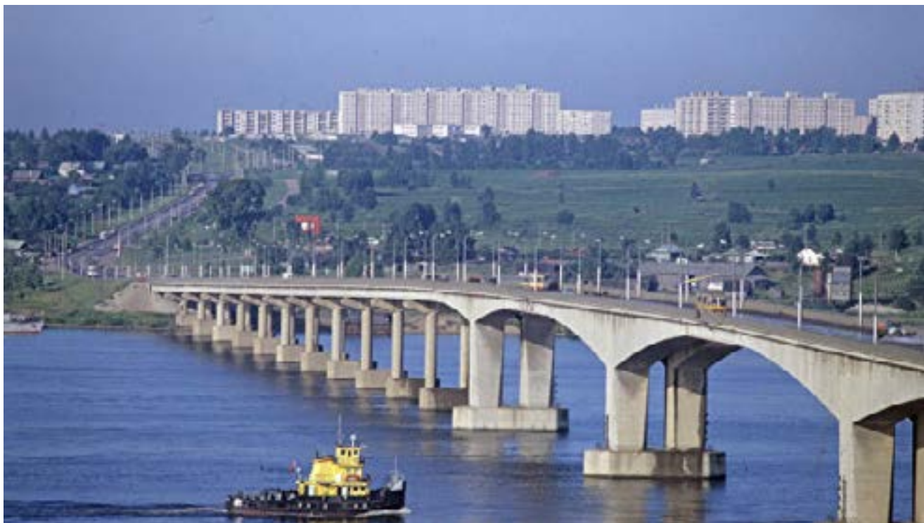
Рис.6. Мост через Волгу в Костроме
