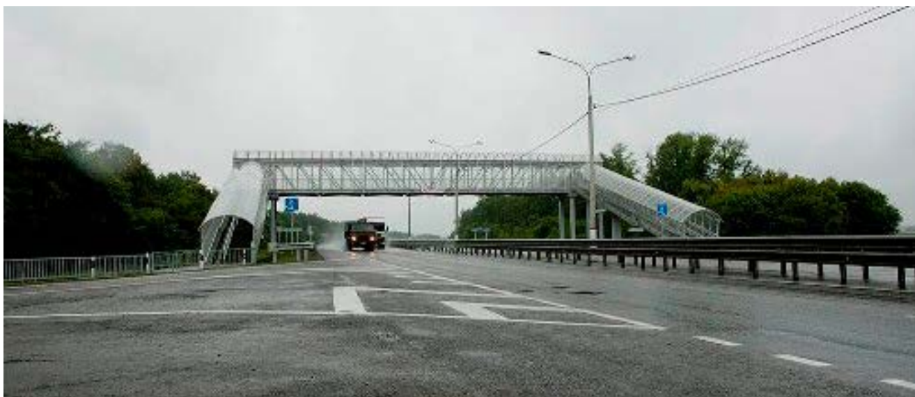
Рис. 2. Пешеходный путепровод на трассе М4 «Дон». Расчетный пролет 32,9 м
