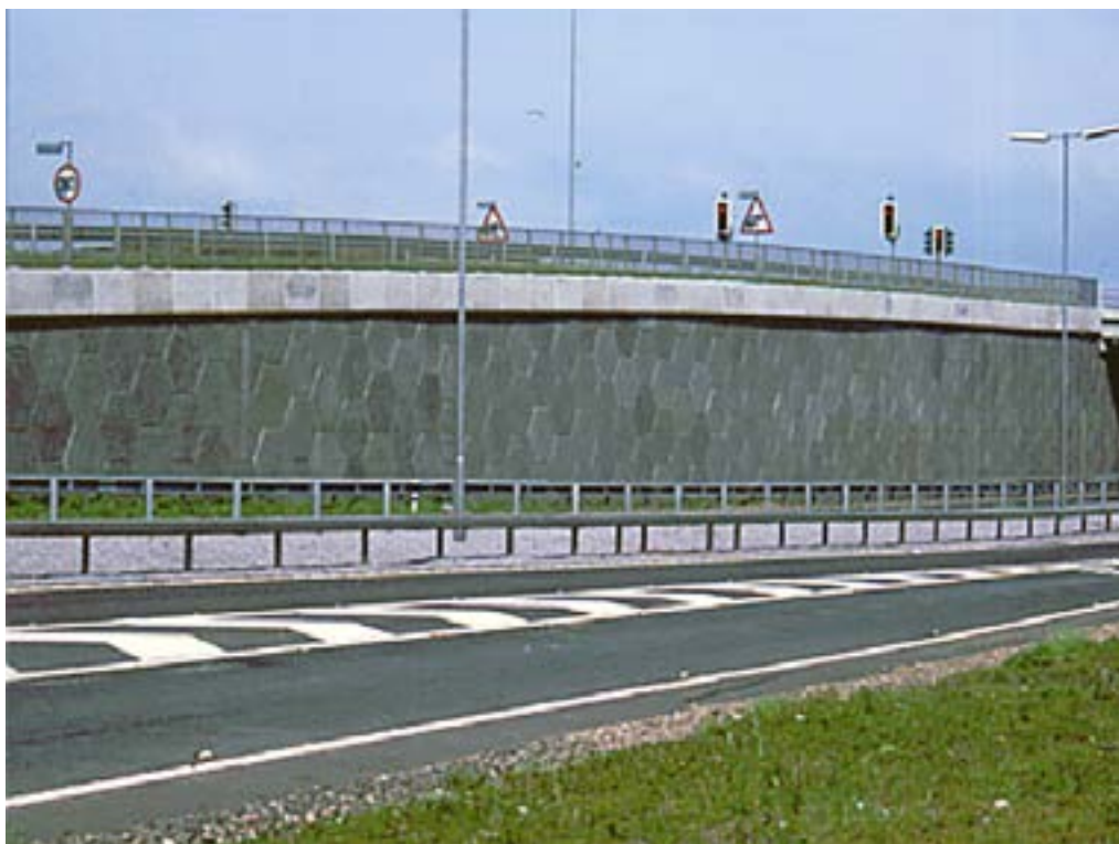
Рис. 2. Армогрунтовая стенка с облицовкой из шестигранных бетонных блоков
