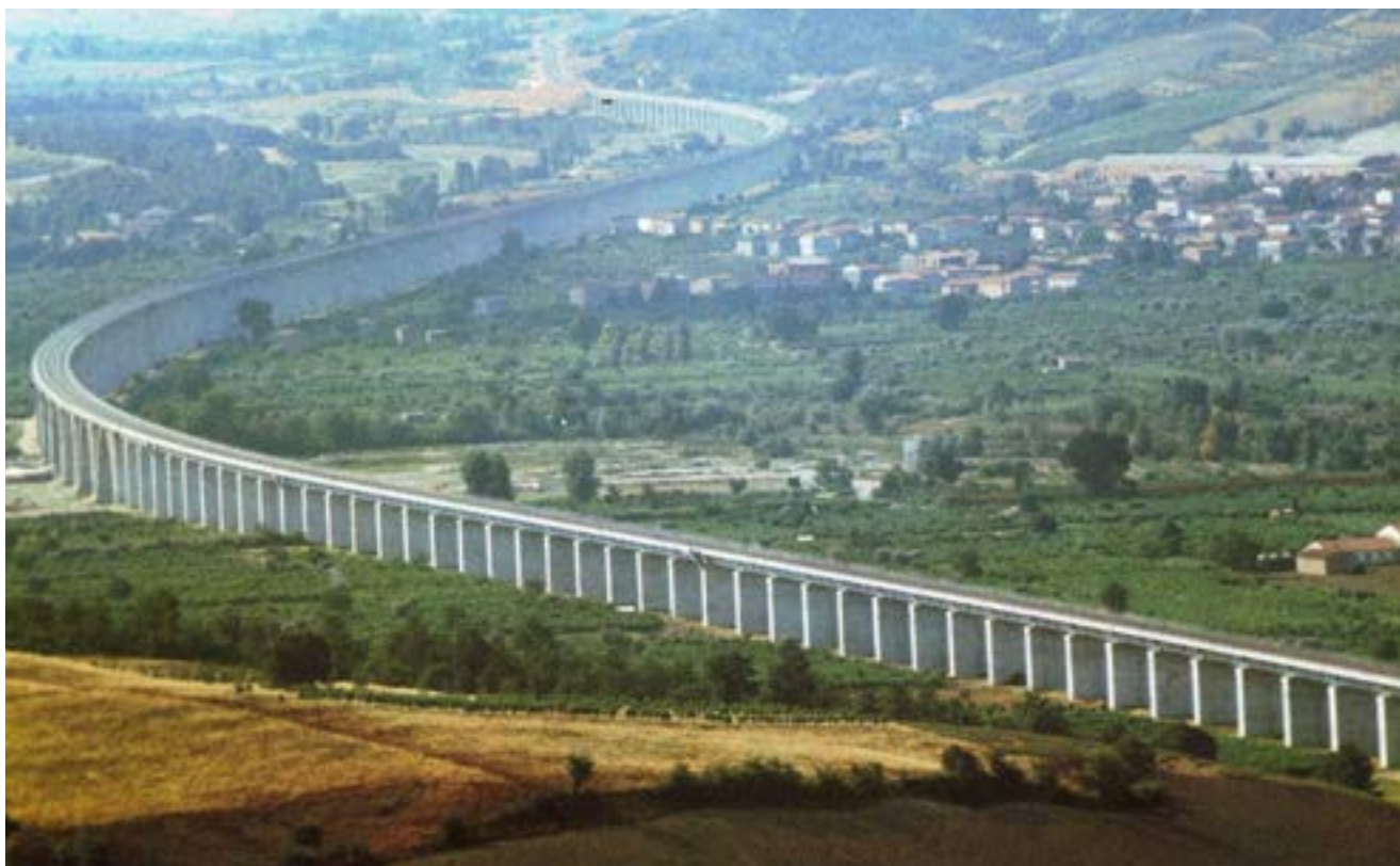
Рис.7. Наглядный пример эстакады, проходящей по незастроенным территориям
