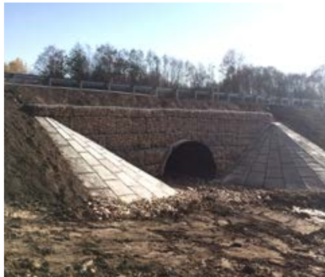
Рис. 7. Фото построенного водопропускного сооружения через реку Галинку в Псковской области
