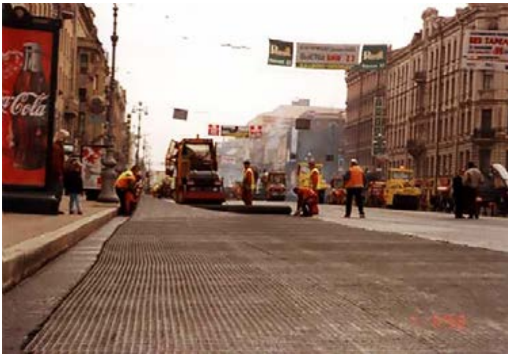
Рис. 1. Укладка георешетки Хателит С на улице Санкт-Петербурга
