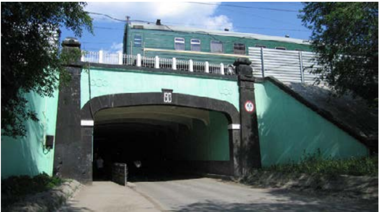
Рис.8. Тоннель под железнодорожной насыпью в Новосибирске
