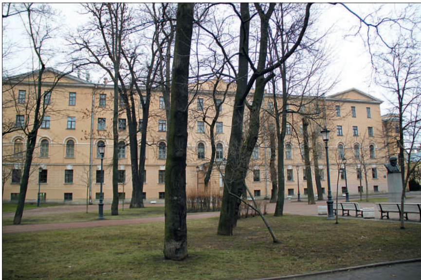
Рис. 9. Императорский Александровский лицей, Каменноостровский пр., д. 21
