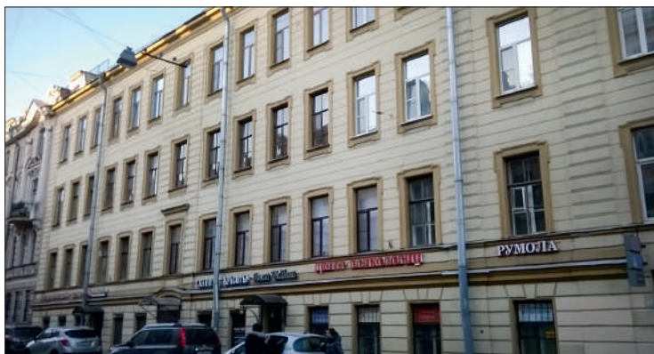
Рис. 23. Дом Крылова и Стеклова на Зверинской ул., 6
