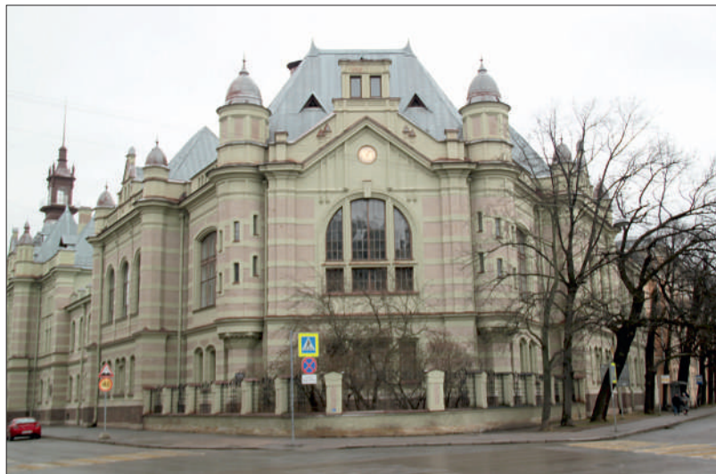
Рис. 14. Главное здание Электротехнического института, ул. Профессора Попова, д. 5
