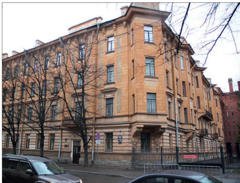
Рис. 15. Профессорский дом Электротехнического института, ул. Профессора Попова, д. 5-Щ
