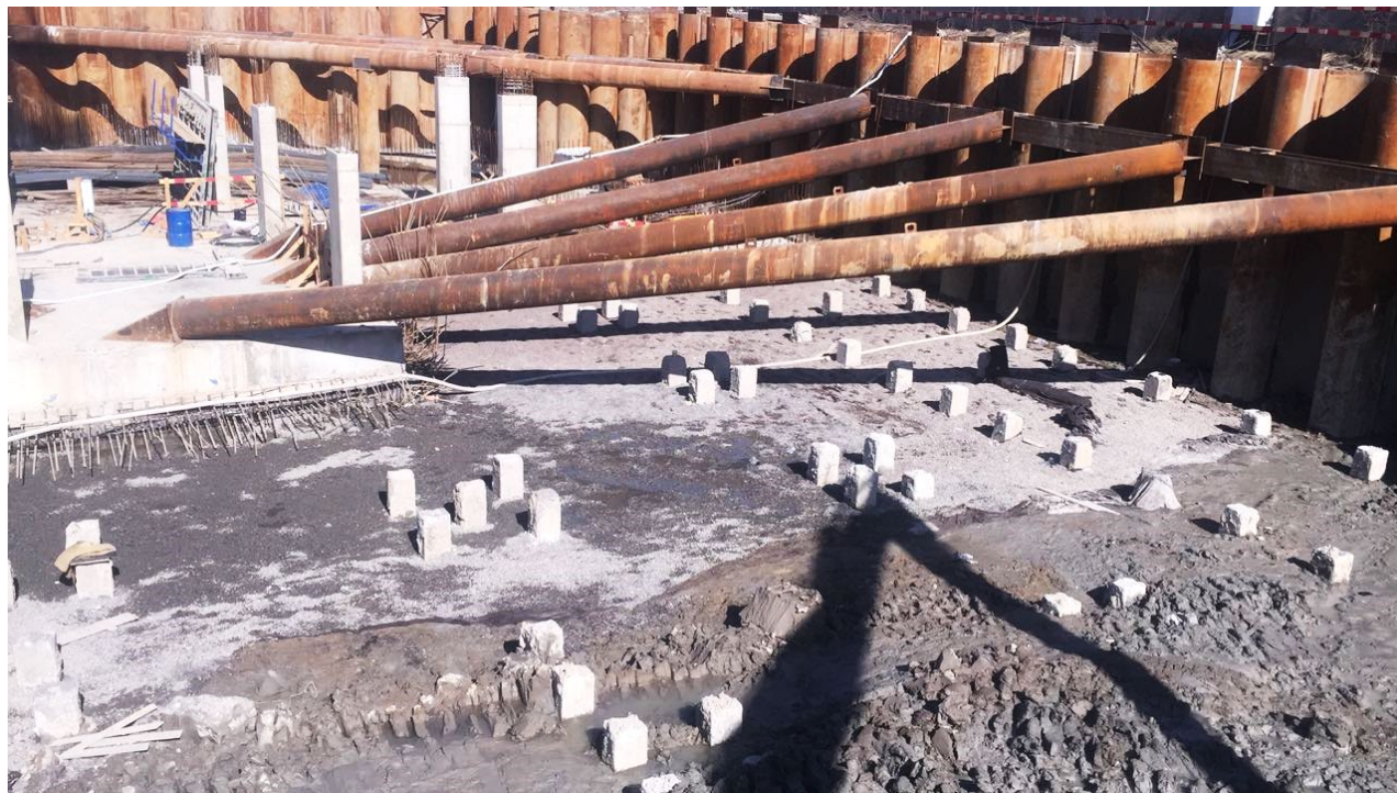
Рис. 1. Сваи, погруженные на проектную отметку с поверхности земли. Глубина котлована 8 м.
